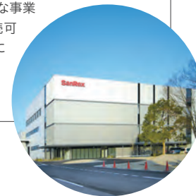
滋賀工場新棟竣工 (2014年)
