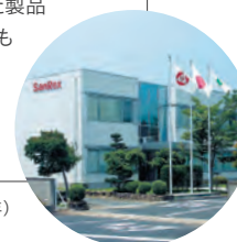
岡山工場竣工(1985年)
