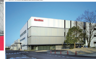
滋賀工場新棟竣工（2014年）
