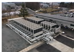
岡山工場 高効率空冷モジュールチラー
