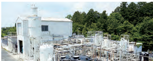
岡山工場 水処理施設
