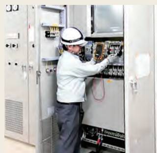
無停電電源装置の点検
