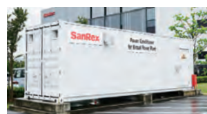
当社滋賀工場に設置されたVPP実証用パワーコンディショナー
