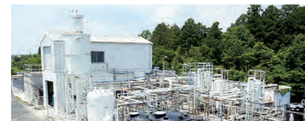
岡山工場 水処理施設
